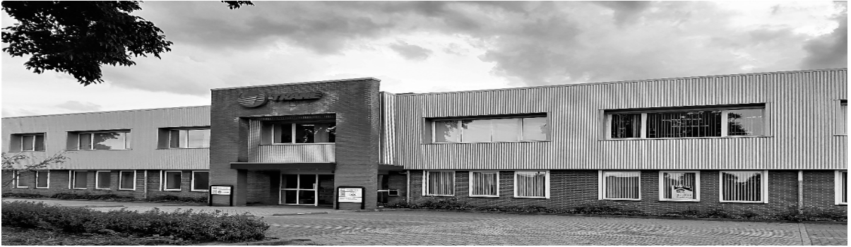
Bedrijfspand Metaverpa in Soest: huidige situatie/ eigenaar (foto Reiniers).
